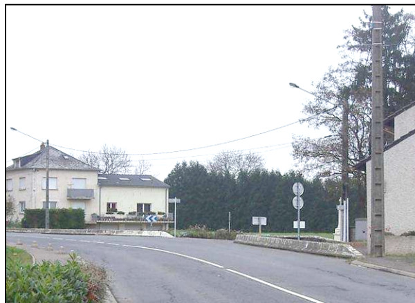
Glissière de sécurité en béton (Chaussée Robert Schuman - RD653)
