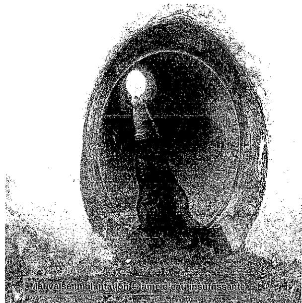
L'ouvrage de franchissement permanent sera installé dans l'axe du ruisseau et respectera le profil en long de manière à conserver en permanence une lame d'eau. Le lit du cours d'eau sera décaissé à ce que le fond de la buse soit suffisamment enterré ( au moins 30cm) de manière à permettre une reconstitution d'un lit naturel dans l'ouvrage. Le fond granulométrique naturel du ruisseau sera reconstitué au sein de l'ouvrage à l'aide de matériaux récupérés sur place.
