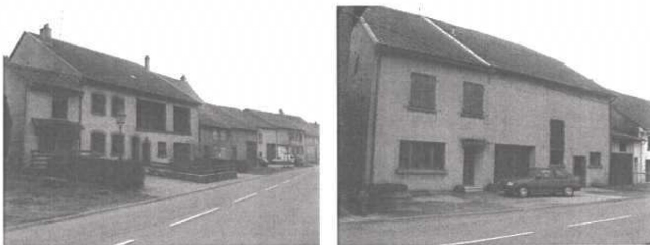
Maisons réaménagées rue Saint Laurent
