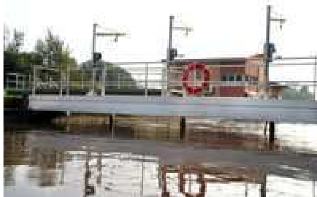
La station d'épuration de Kerbach « Moulin Neuf »
