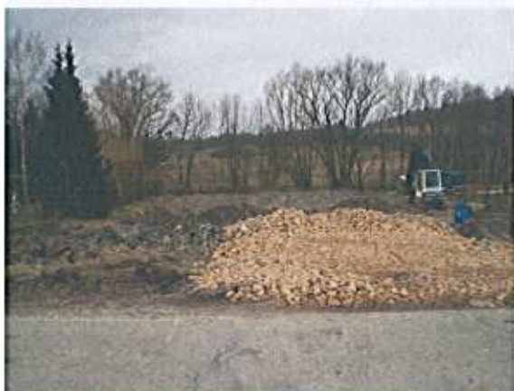
Maison en cours de construction
