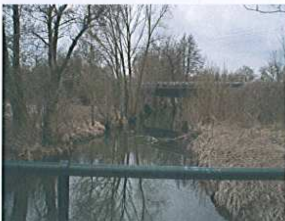
Ruisseau l'Anzeling et la voie ferrée
