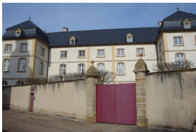
Vue depuis la rue des Moulins
