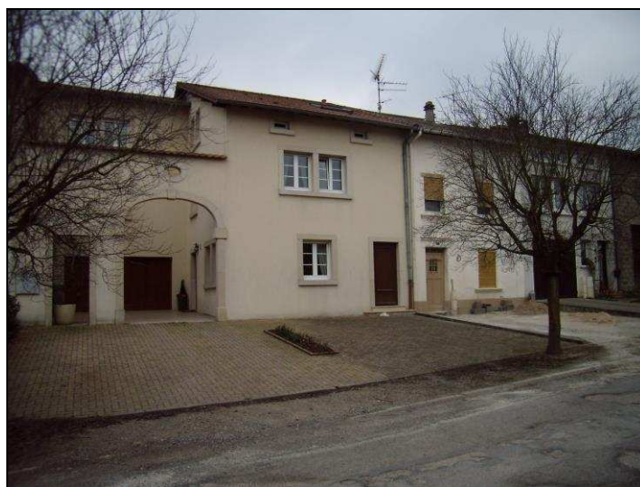
Réhabilitations existantes au sein du village – Source : Topos
