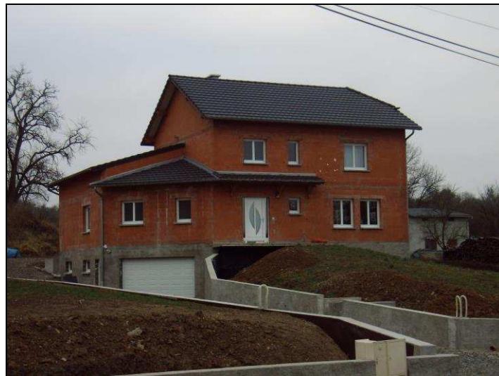
Habitation en construction à VAUDRECHING – Source : Topos
