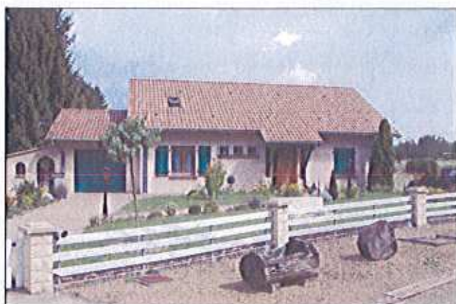
Pavillon des années 90-2000 rue de la Carrière
