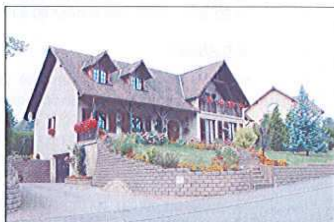
Pavillon des années 80-90 rue du Cimetière
