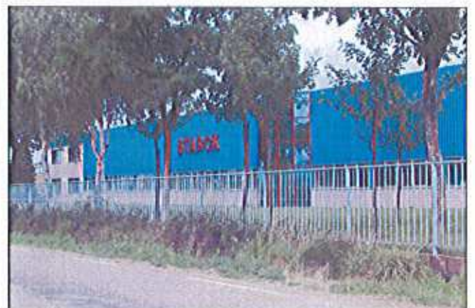
Bâtiment d'activités - entreprise STARCK route de Bouzonville
