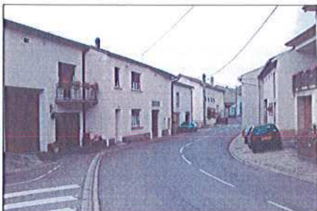
Bâti ancien - maisons de village-rue rue Principale
