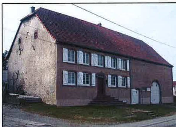
Fenêtres alignées, volets battants en bois et grand perron pour cette ferme lorraine, rue du
