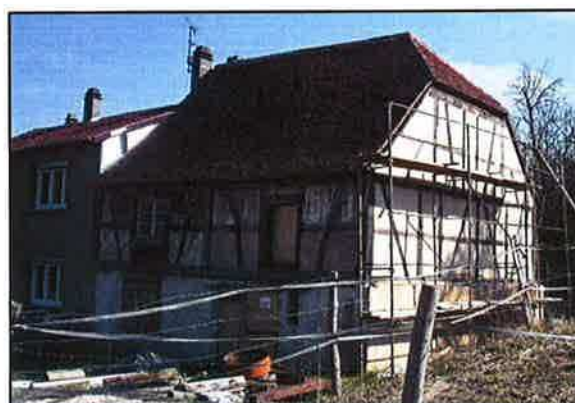
« Maison d'Emilie » en rénovation, rue Saint-Jacques.
