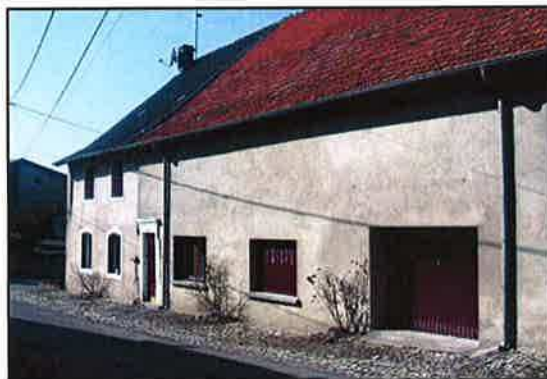
Ferme à moitié reconstruite, rue de la Synagogue.
