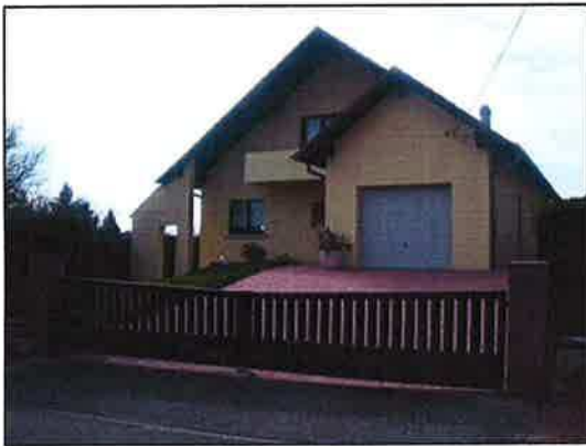
Pavillon rue de la Forêt : faîtage perpendiculaire, entrée surélevée, haies et clôture en limites de parcelle.
