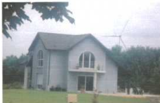
Maison récente, style pavillonnaire
