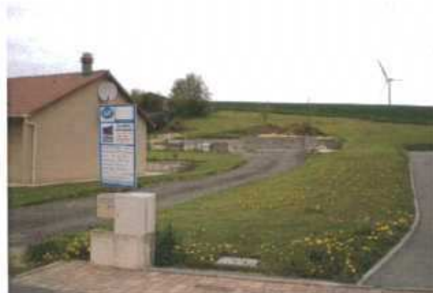
Construction en cours de réalisation
