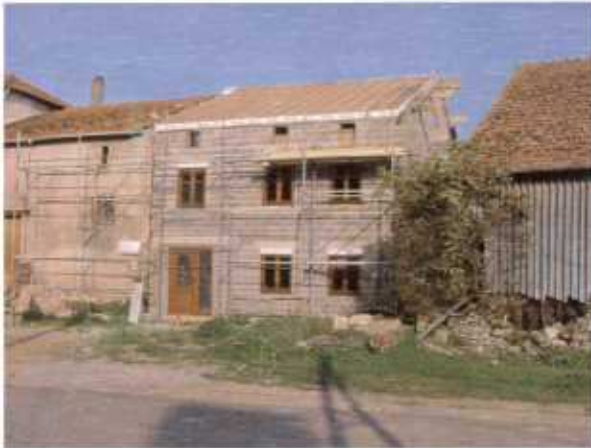
Une réhabilitation en cours
