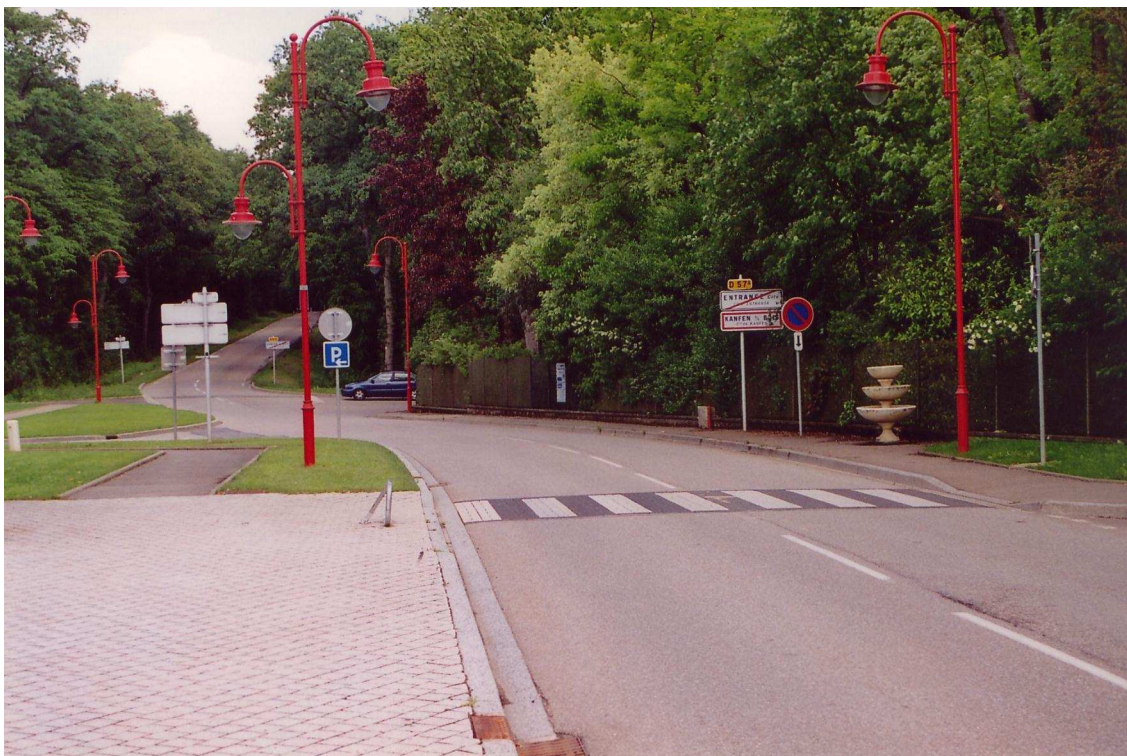
Entrée de KANFEN-SOUS-BOIS par RD57a, côté ENTRANGE.
