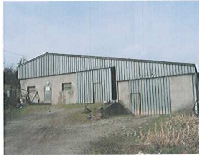
Un hangar est situé en entrée d'agglomération.
