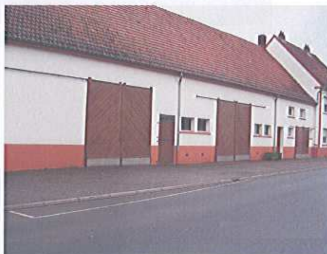
RD 956 à Bizing : maisons traditionnelles rénovées, usoirs macadamés servant de parking.
