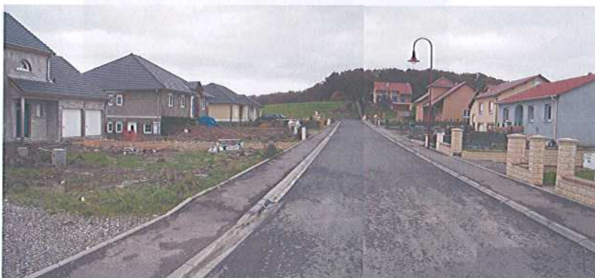
Constructions très récentes – Rue de Beaumont à Bizing
