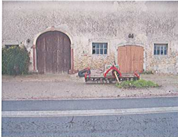
Porte charretière et large usoir dans la rue du Lavoir à Grindorff
