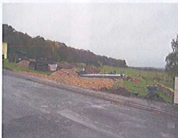
Maison en cours de construction – rue de la Forêt à Grindorff
