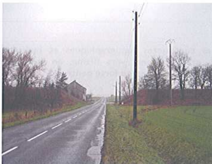
Talus SNCF de part et d'autre de la route vers Halstroff
