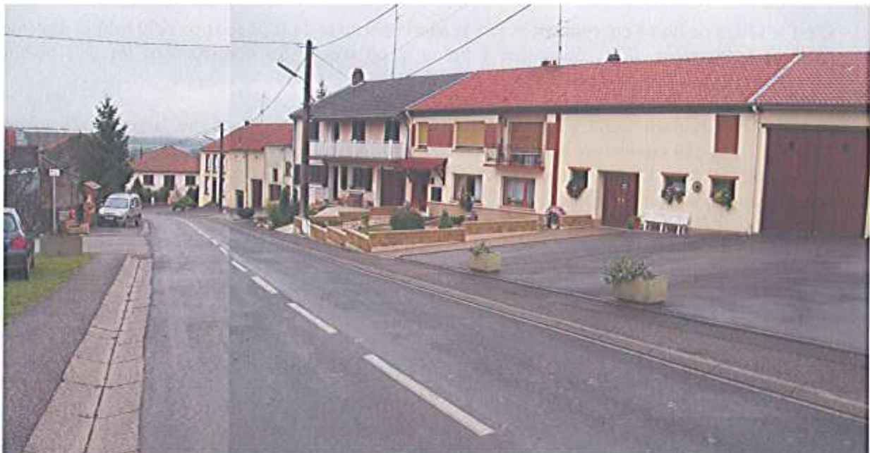
Grand'Rue à Grindorff : village-rue, usoirs rénovés, toitures au faitage rouge parallèle à la rue
