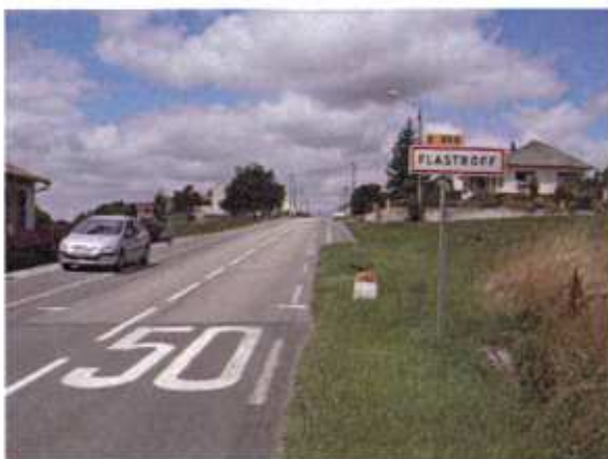
Maisons récente le long de la RD 956.
