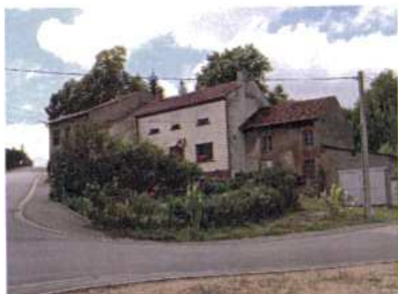
Ilot d'habitations à Flastroff
