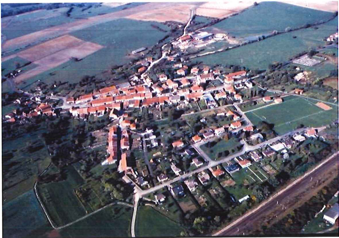
Vue aérienne de RECHICOURT-LE-CHÂTEAU et le développement du bâti linéaire le long de la voie ferrée au premier plan.
