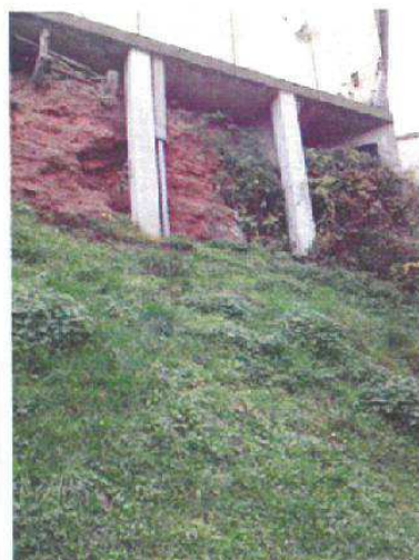
Illustration n°4 - Piliers soutenant la terrasse de M. et Mme SALHING et renforcement du refend.
