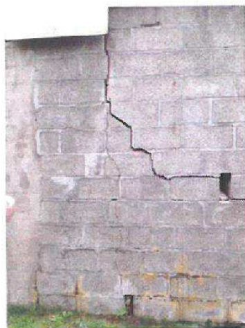
Illustration n°3 - Désordres affectant les murs de soutènement.
