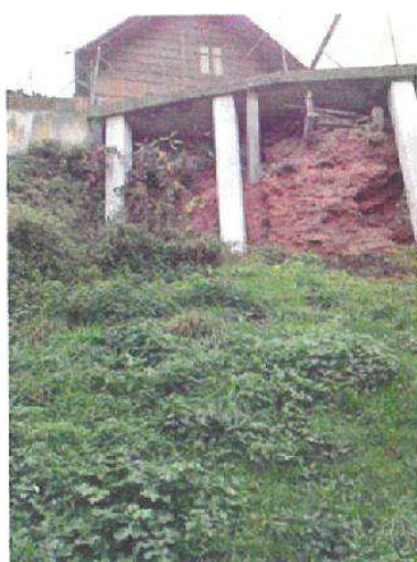
Illustration n°4 - Piliers soutenant la terrasse de M. et Mme SALHING et renforcement du refend.
