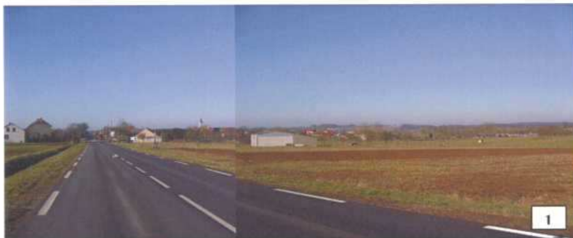
Vue de la RD 38 en venant de Mittersheim
