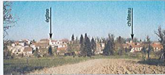
L'église et le château qui marquent la silhouette du village
