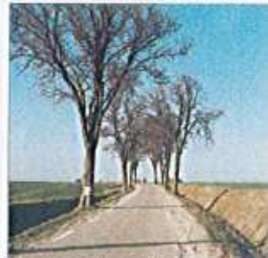
La RD 22 d, qui relie la RD 38 et la RD 22 en passant par Bidestroff
