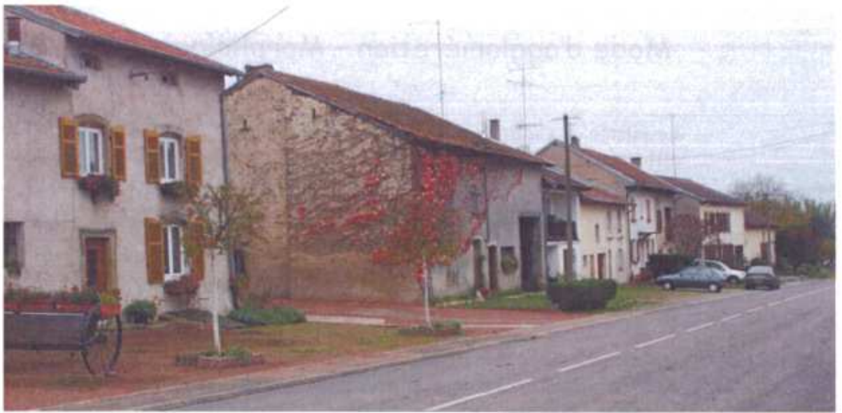
Rue Jean Martin Moye – bâti continu et mitoyen – façâtes parallèles à la rue
