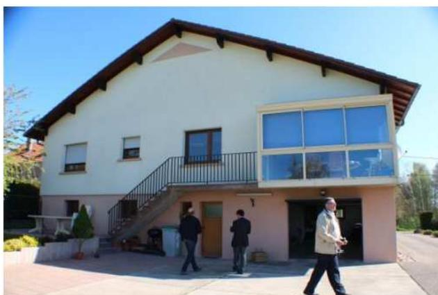
Figure 2.16 : exemple d'une irrégularité engendrée par un porte-à-faux
