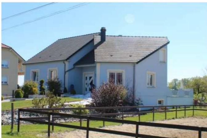
Figure 2.15 : exemples d'une irrégularité engendrée par une différence de hauteurs de deux corps de bâtiment
