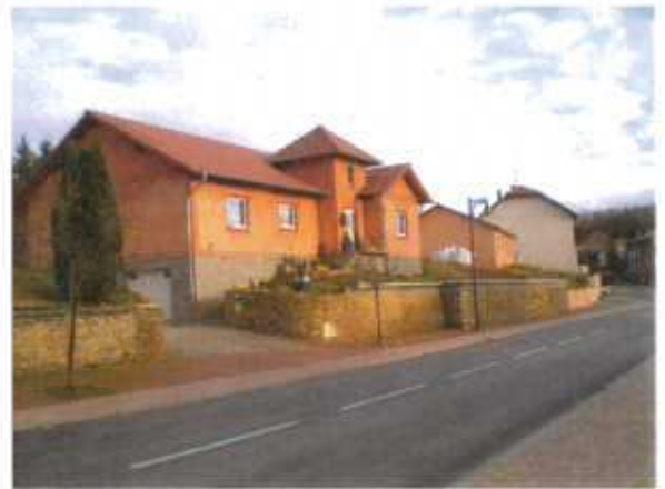
Construction neuve dans une dent creuse
