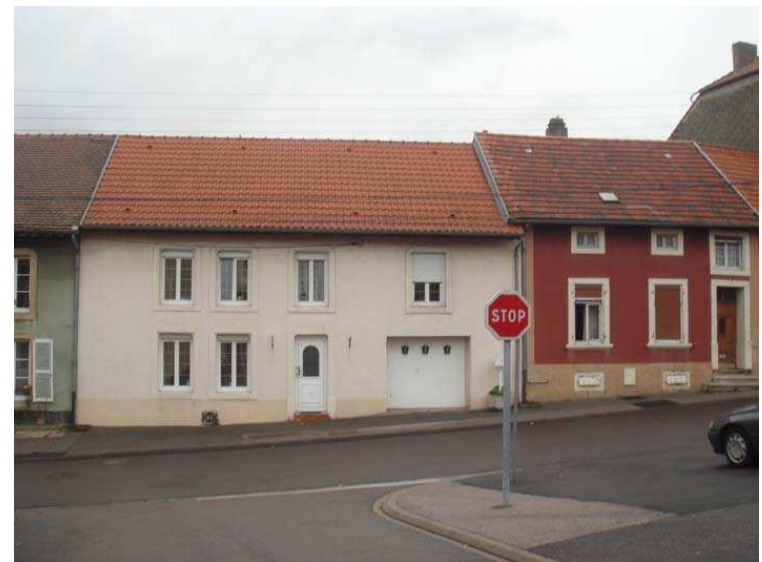
Exemple de réhabilitation réussie
