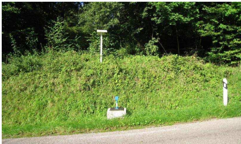
Borne signalant le passage du pipeline « Oberhoffen-Carling » sous la RD103r
