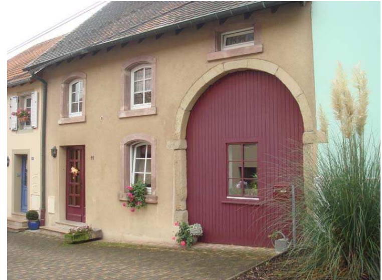
Exemple de réhabilitation réussie
