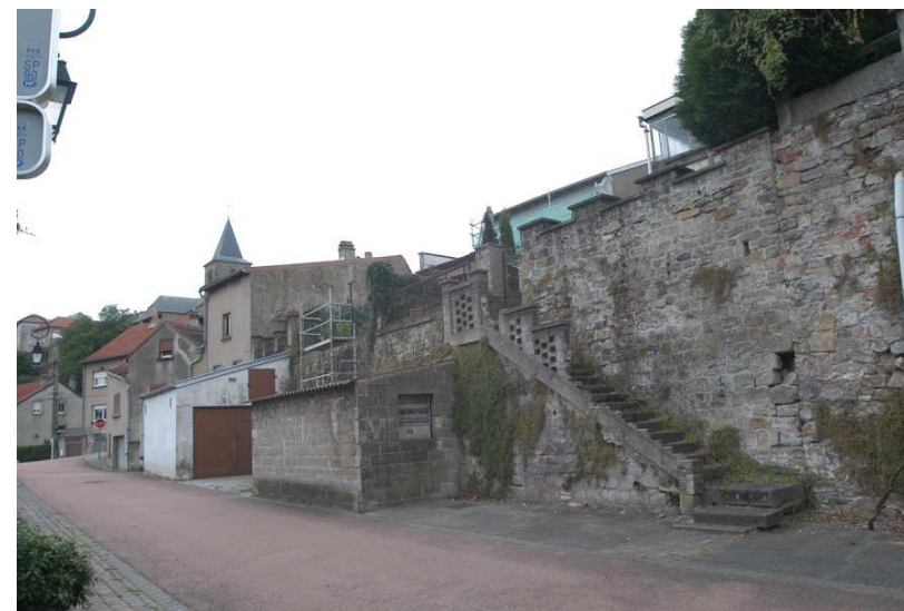
Vue du rempart Nord
