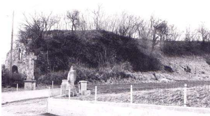
Le Fallbrück, au milieu du XX ème siècle, débouché Est
