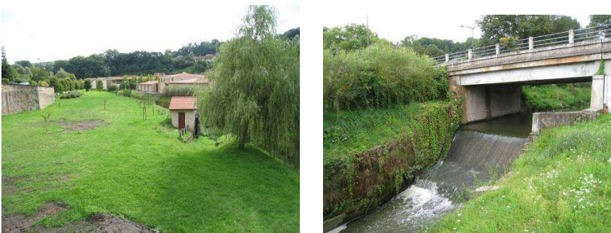
Lit majeur de la Rosselle dans la zone urbanisée de Hombourg
