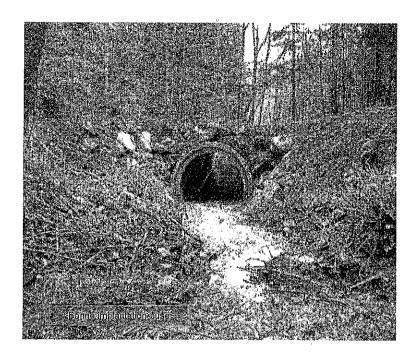
Le positionnement de la buse au niveau de la traversée sous la RD 86 par rapport au lit du ruisseau ne doit faire obstacle à la libre circulation des espèces biologiques, au bon déroulement du transport des sédiments et de l'écoulement du cours d'eau de l'amont vers l'aval.
