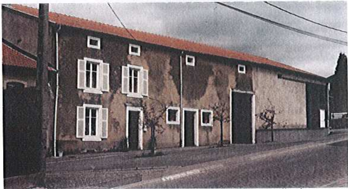
Les percements des bâtiments les plus anciens sont soulignés par des encadrements de pierre.
