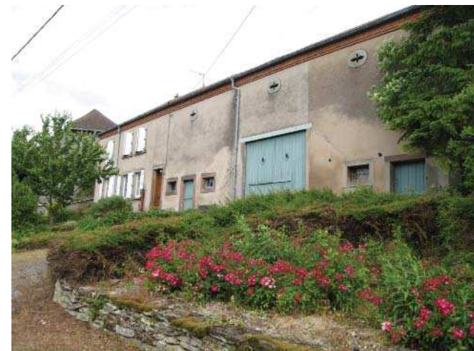
Les anciennes fermes constituent une part importante du bâti du centre.
