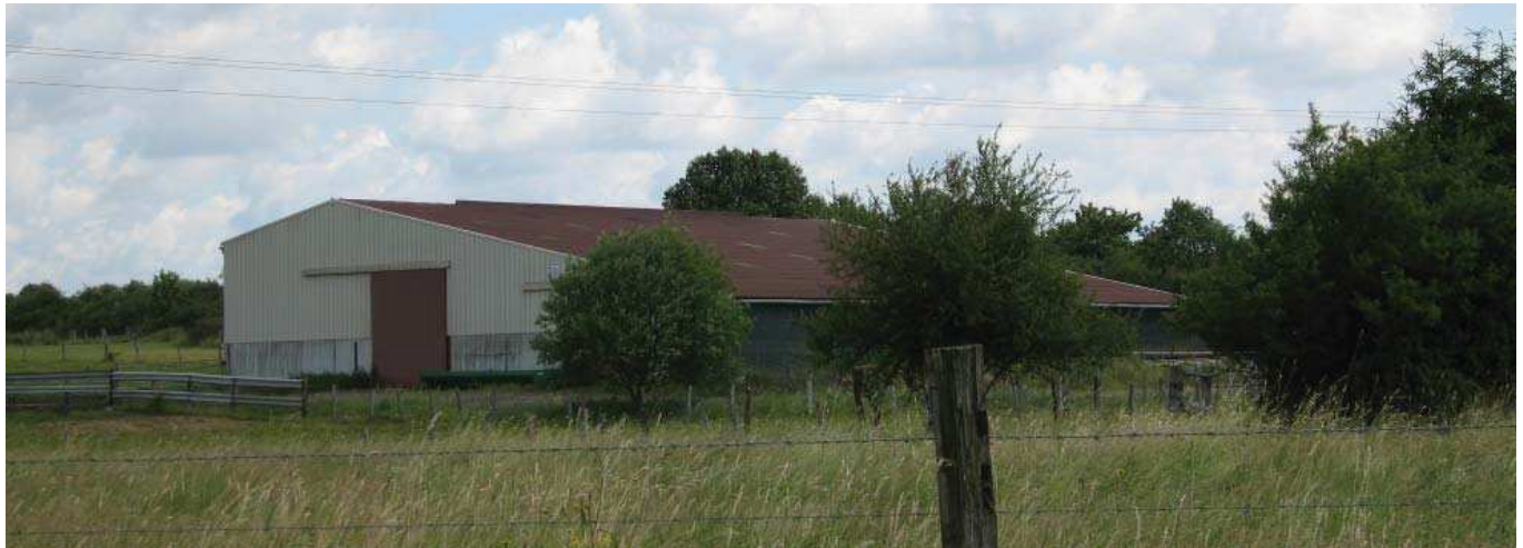
Bâtiment agricole à Wentzwiller
