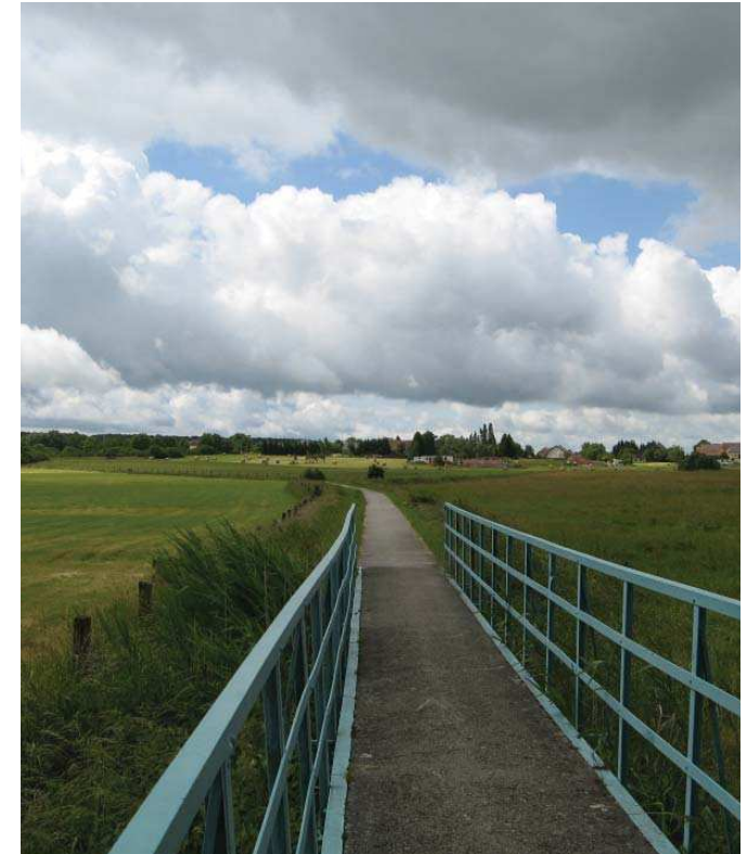
Passerelle entre Val de Guéblange et Audviller
