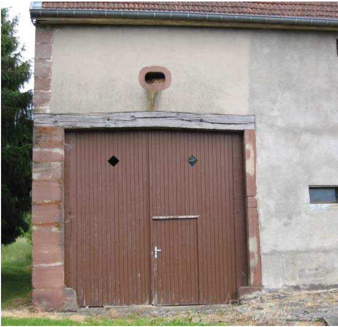
Détail d'architecture sur le linteau en bois, le chaînage en grès et le jambage.
