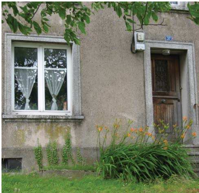
Encadrement en béton des années 1950
