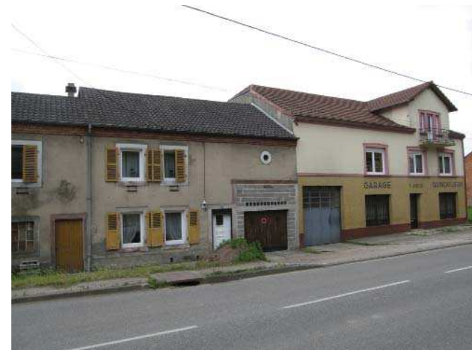
Bâti en ordre continu à Schweix, comme dans les autres bourgs le faitage est parallèle à la voirie.
