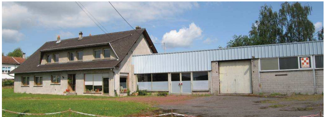
Ancien garage à Wentzwiller
