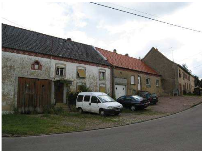
Les maisons sont relativement basses et s'adaptent à la pente du terrain.
