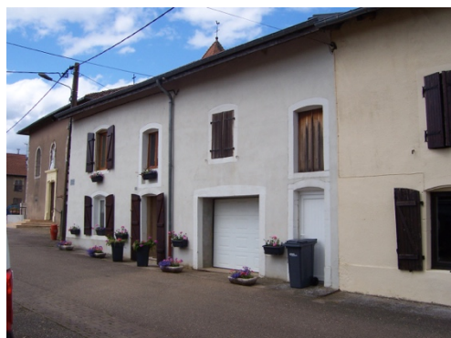
Alignement de maisons , rue du Lavoir
