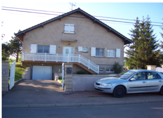
Maison avec faîtiage perpendiculaire à la rue, rue des Deux Villes
