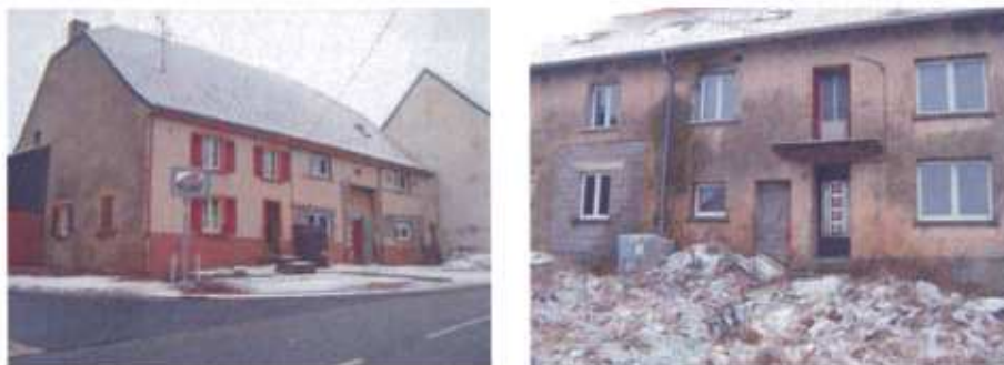
Illustration 28 : Exemple de bâtiments en réhabilitation
