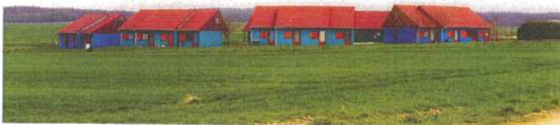
Des constructions qui s'affirment dans le paysage.
