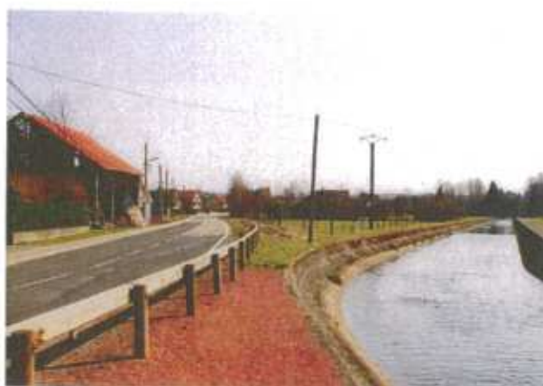
La R.D.44 tangente le canal d'alimentation au bas du vieux village.
