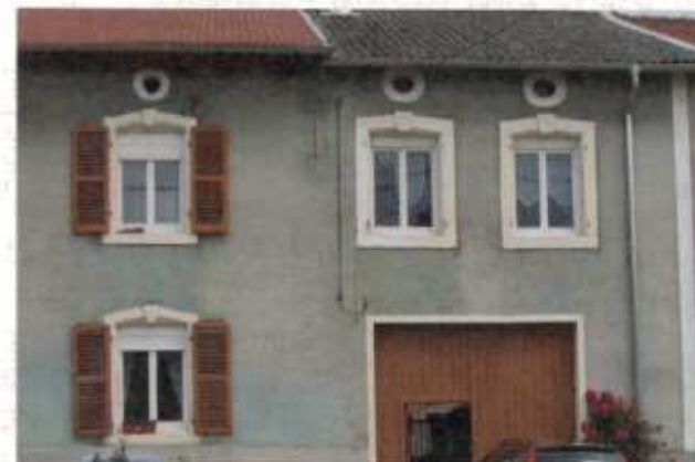
Maison datant de la fin du XIX ème siècle, encadrements en arcs surbaissés avec clefs
