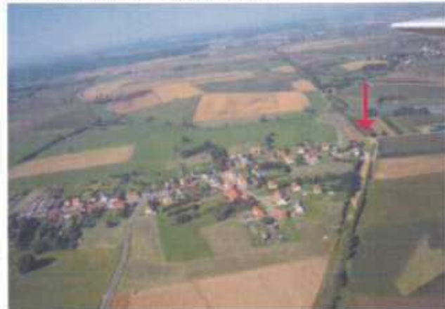
Ancienne ligne de chemin de fer
