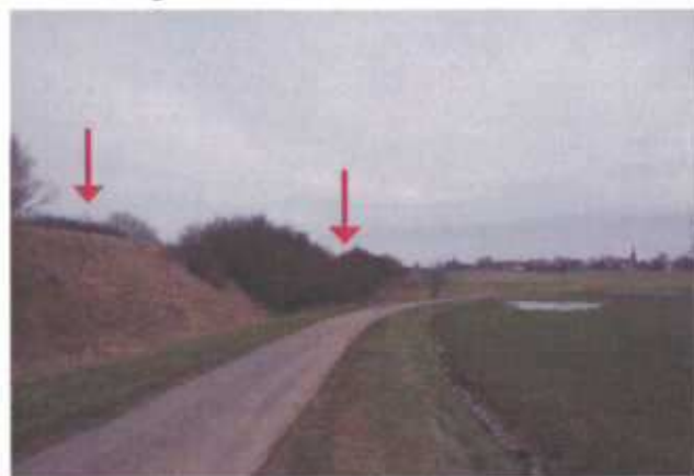
Ancienne ligne de chemin de fer
