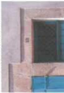
*Surépaisseur de l'enduit due à un enduit projeté monocouche*
