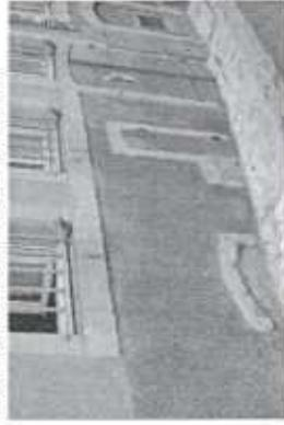
Pas de remontée d'étanchéité visible en pied de mur.
