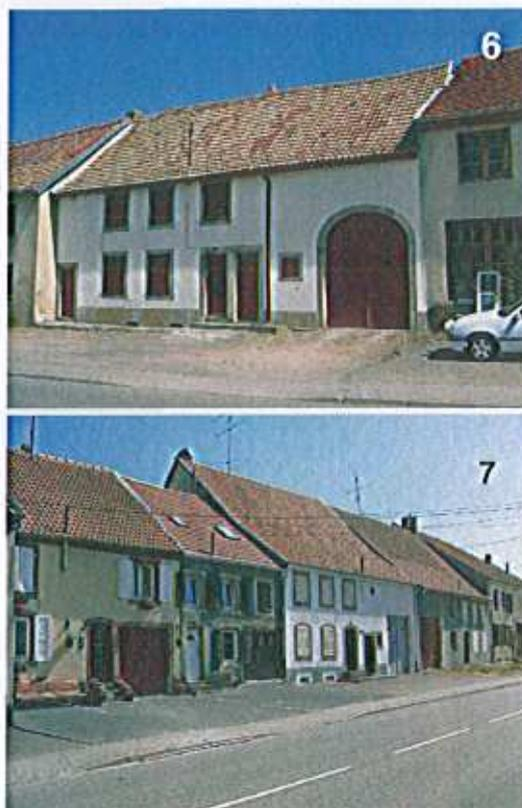
Les toitures sont généralement à deux pans et présentent des pentes moyenne à forte de 25 à 50°, les toitures peuvent présenter une croupe en toiture et sont rarement percées. Les tuiles sont de couleur rouge (terre cuite traditionnelle).
