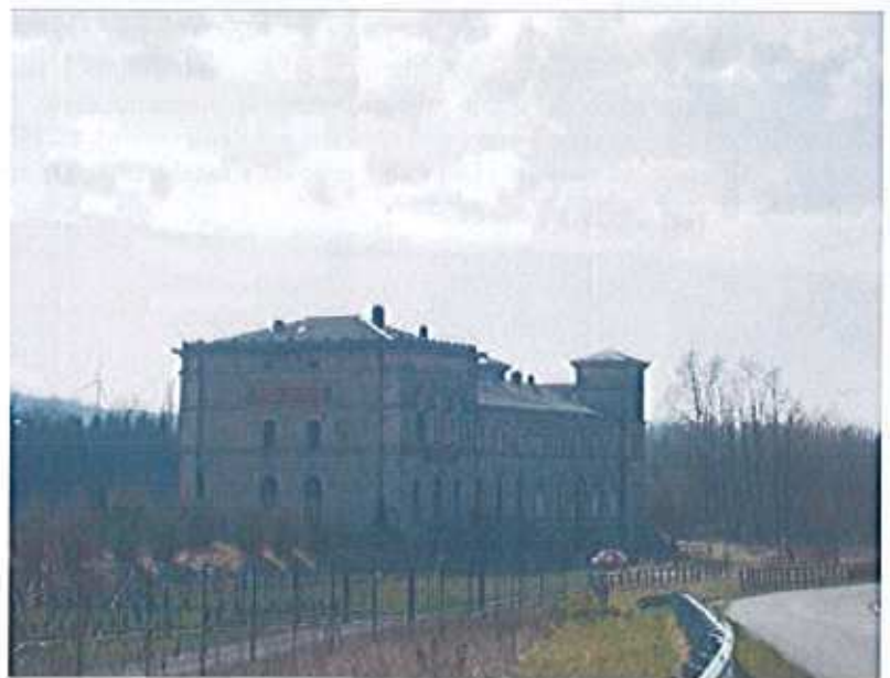
Vue depuis le Nord
