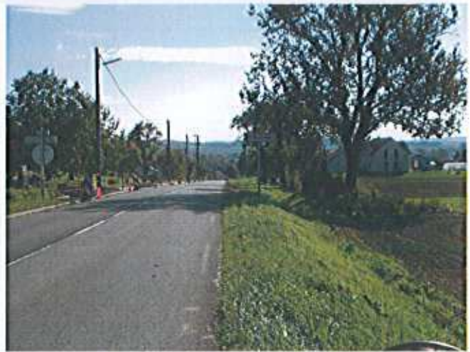
Entrée Nord-ouest de GOMELANGE
