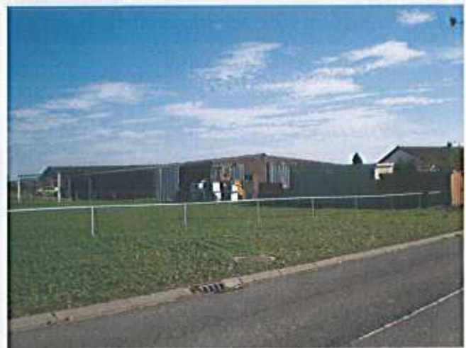
Ferme au Nord-ouest
