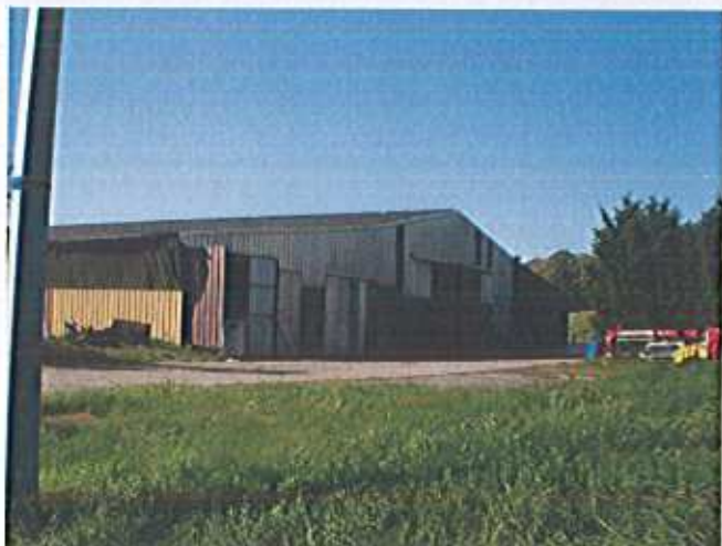
Ferme au Nord-ouest
