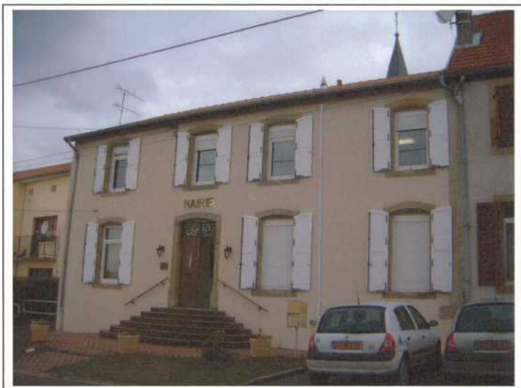
Mairie et Ecole de Vahl les Faulquemont
