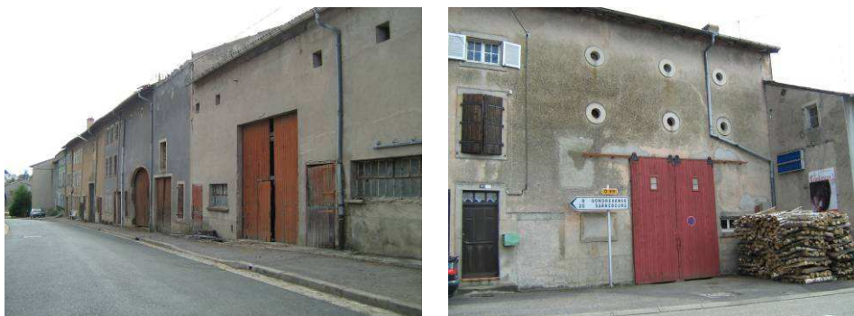
Illustration 35 : Façades du centre ancien illustrant la diversité des ouvertures
