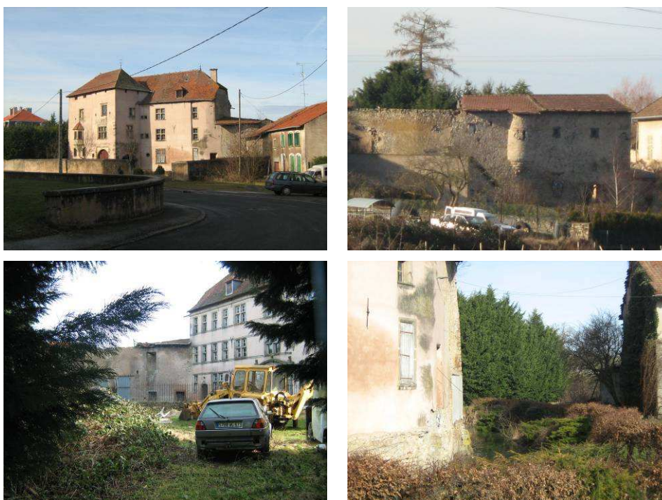
Illustration 30 : Vues sur le château et ses abords immédiats
