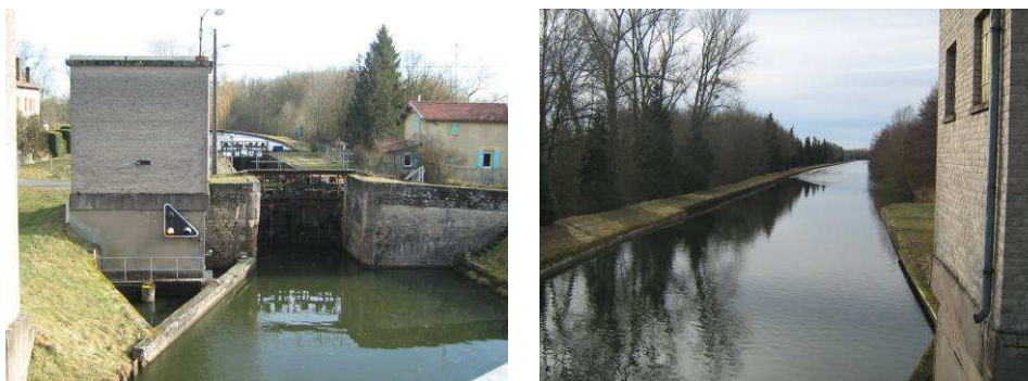
Illustration 24 : Vues sur le canal de la Marne au Rhin et ses écluses
