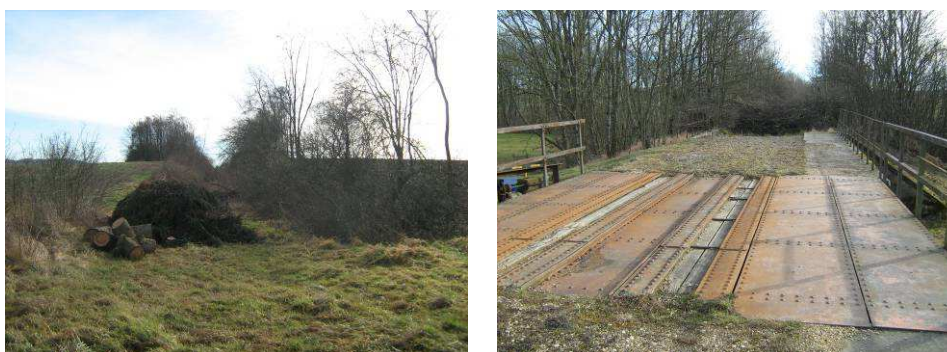
Illustration 22 : Vues sur le tracé de l'ancienne voie ferroviaire desservant le site d'Hellocourt et sur l'ancien pont ferroviaire au-dessus du canal
