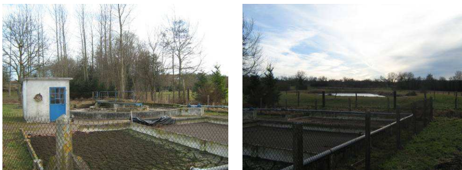
Illustration 74 : Station d'épuration de Réchicourt le Château
