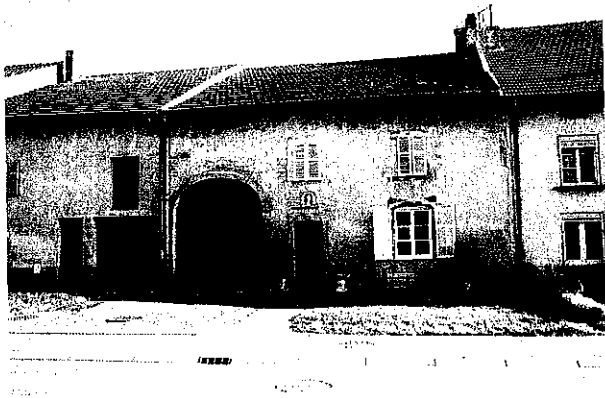
Maison lorraine avec un usoir réaménagé
