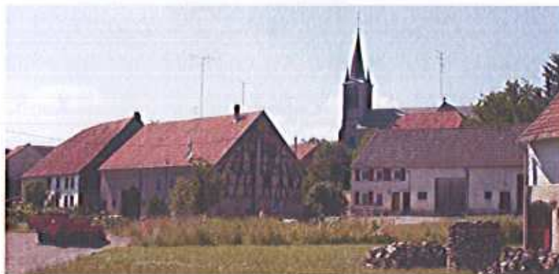
Configuration « village tas » autour de l'Eglise Saint-Barbe
