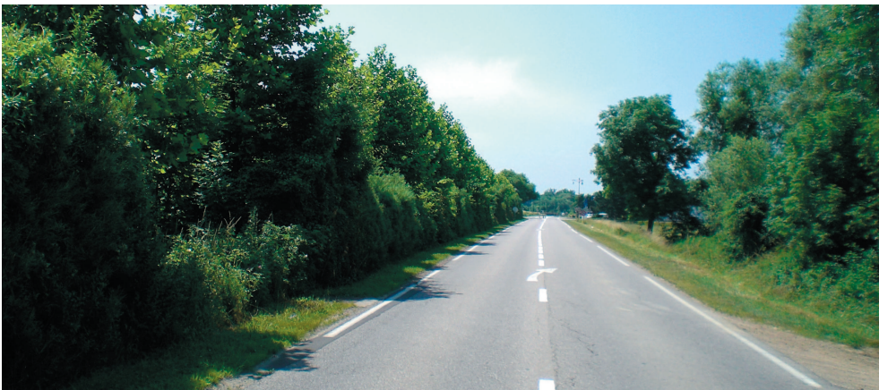
La départementale n°6
