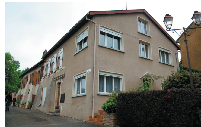
Reconstruction sur une partie XIXème
