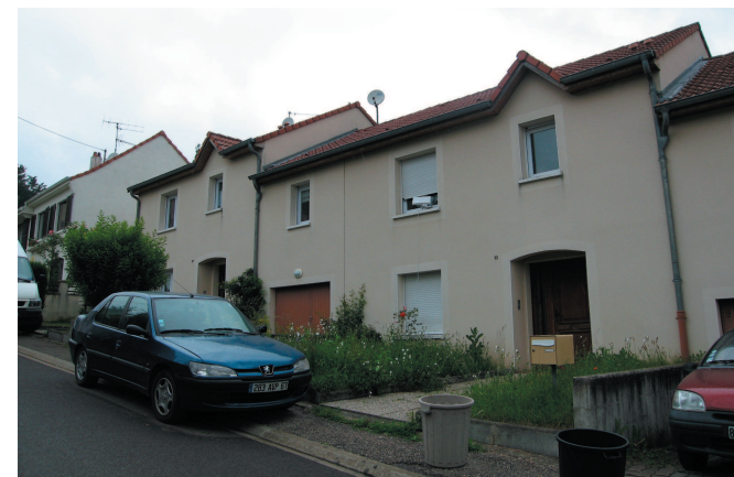
Maisons jumelées sur la « grand rue »
