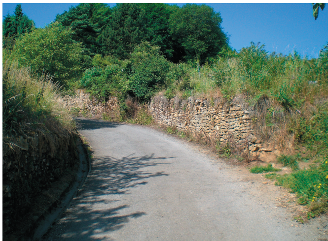
Murs en pierre comme soutènement
