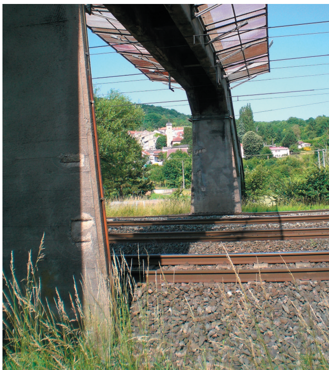
Passerelle SNCF en béton armé.
