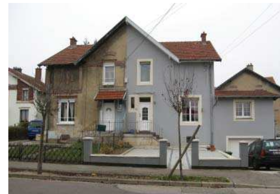
Maisons jumelées de cité, avec pignon secondaire sur la rue
