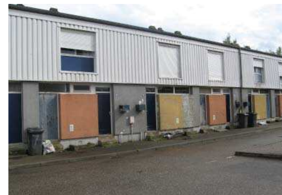
Constructions en bande plus récentes, quartier du Grosskirfeld
