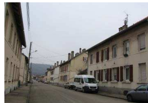
Constructions en bande de cité minière
