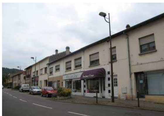
Bâti en ordre continu R+1 avec des activités en RdC
