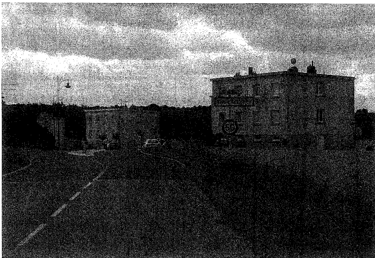
Entrée de ANGEVILLERS, par RD59b, coté ROCHONVILLERS.
