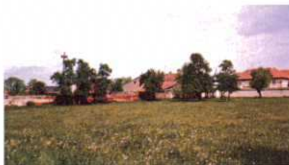
Les limites du parc du château marquées par un mur avec en fond une tourelle classée.
