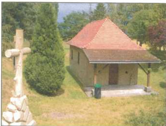
Chapelle située au bord de la voie communale 1 (dans le prolongement de la rue de Hémering).
