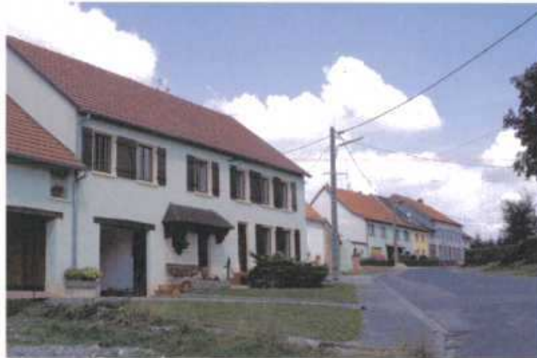
Rue Principale au droit de l'église, bâti parallèle à la rue
