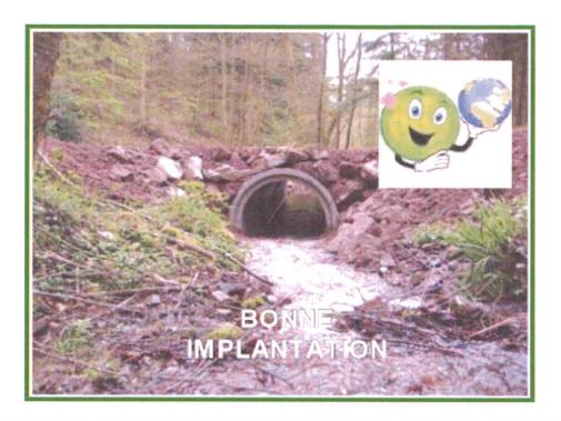
Le franchissement doit être réalisé dans une section rectiligne du ruisseau et hors zones de méandres, d'érosion de pente et de zones instables pouvant favoriser l'affouillement du lit du ruisseau.
