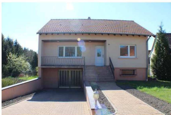
Figure 3.1 : Une maison individuelle en pente
