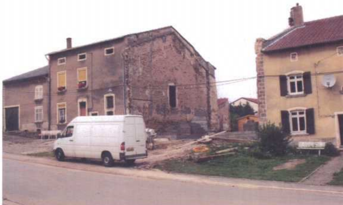
photo n°9 : construction d'un immeuble dans une « dent creuse » du milieu du village.
