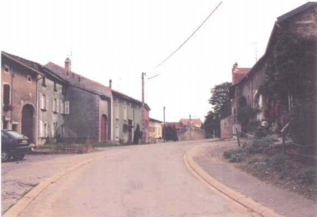
photo n°5 : au premier plan à droite, vieille ferme basse avec linteau de grange arrondi, à gauche les bâtiments sont plus hauts avec indifféremment l'utilisation du grès et du calcaire. La troisième ferme présente un linteau rectangulaire.
