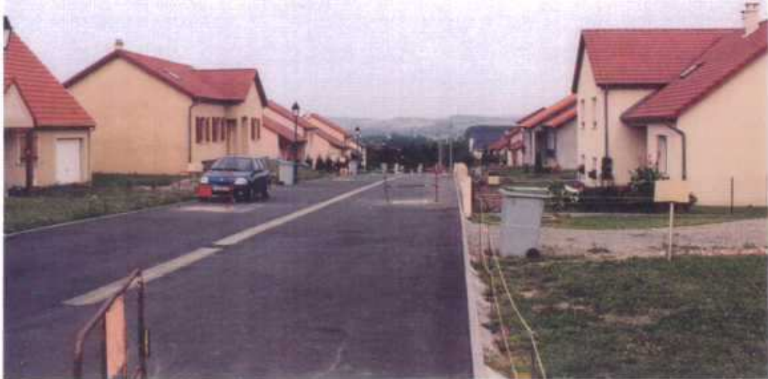
photo n°2 : lotissement communal à l'amont du village.
