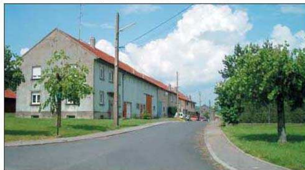
Séquence bâtie, rue de Cap
