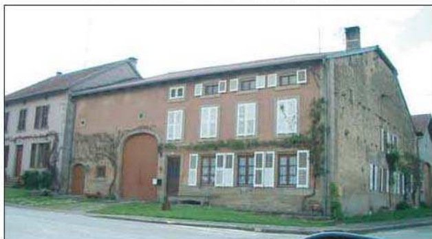
Ferme ancienne rue de Tanconville
